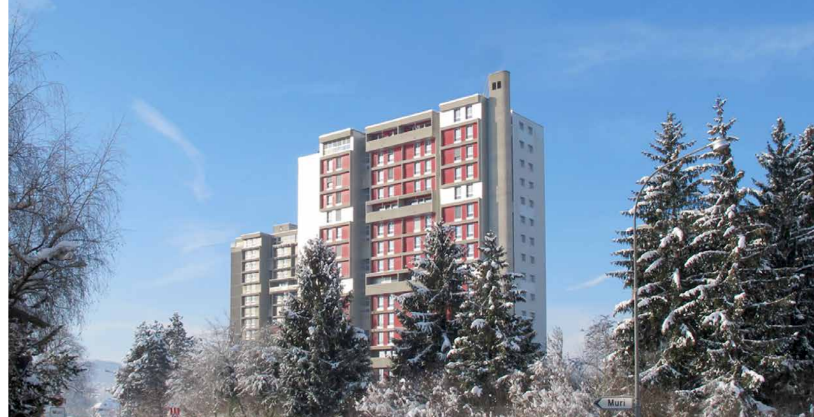
Sanierung eines Mehrfamilienhauses in Muri bei Bern
